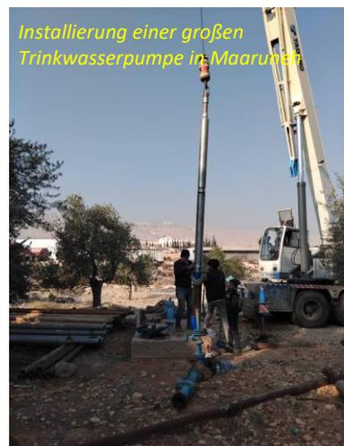
*Installierung einer großen Trinkwasserpumpe in Maaruwa*
